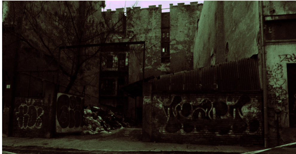
/kis diófa utca 14. /bontott épület_kétemeletes eklektikus lakóház /jelenleg_parkolo /1871 /építész_rill imre
